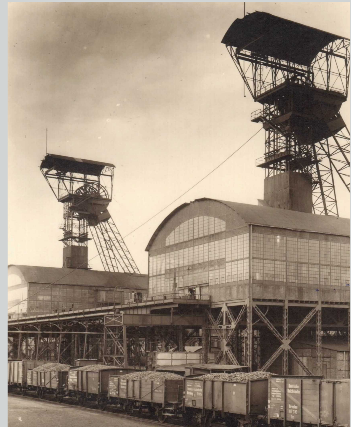
Blick von Südwesten auf die Fördergerüste (mit Tonnendächern) 1959 © Bildarchiv Josef Hesse
